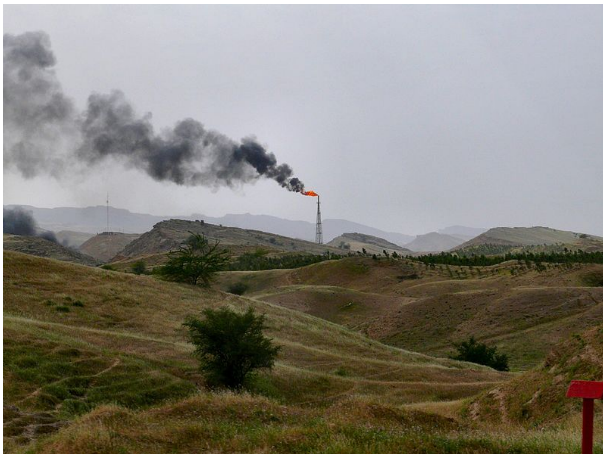
Cheminée de torchage, dans le champ pétrolifère de la province de Khuzestan - © Dynamosquito
